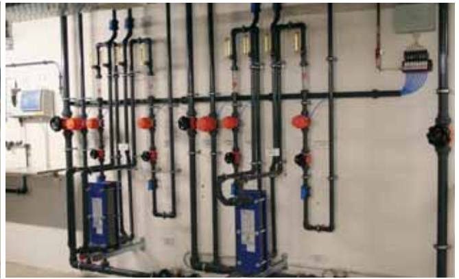
Stetszu- und ablauf mit Wärmerückgewinnung
