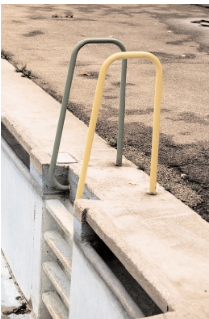
Ausstieg Lehrschwimmbecken (vor Erneuerung)
