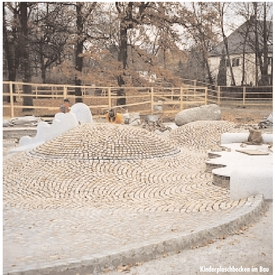
Kinderplischbecken Ungerbad mit Kleinkinderrutsche und Schläunden als Anschluß für die Rücklaufleitung
