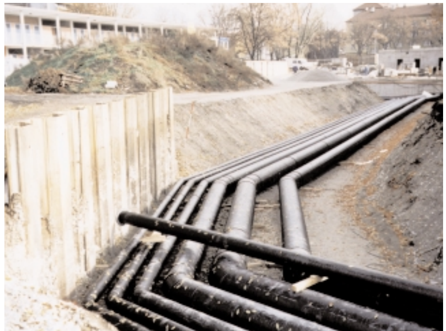
Die breiten Rohrtrassen erfordern enorme Grabarbeiten
