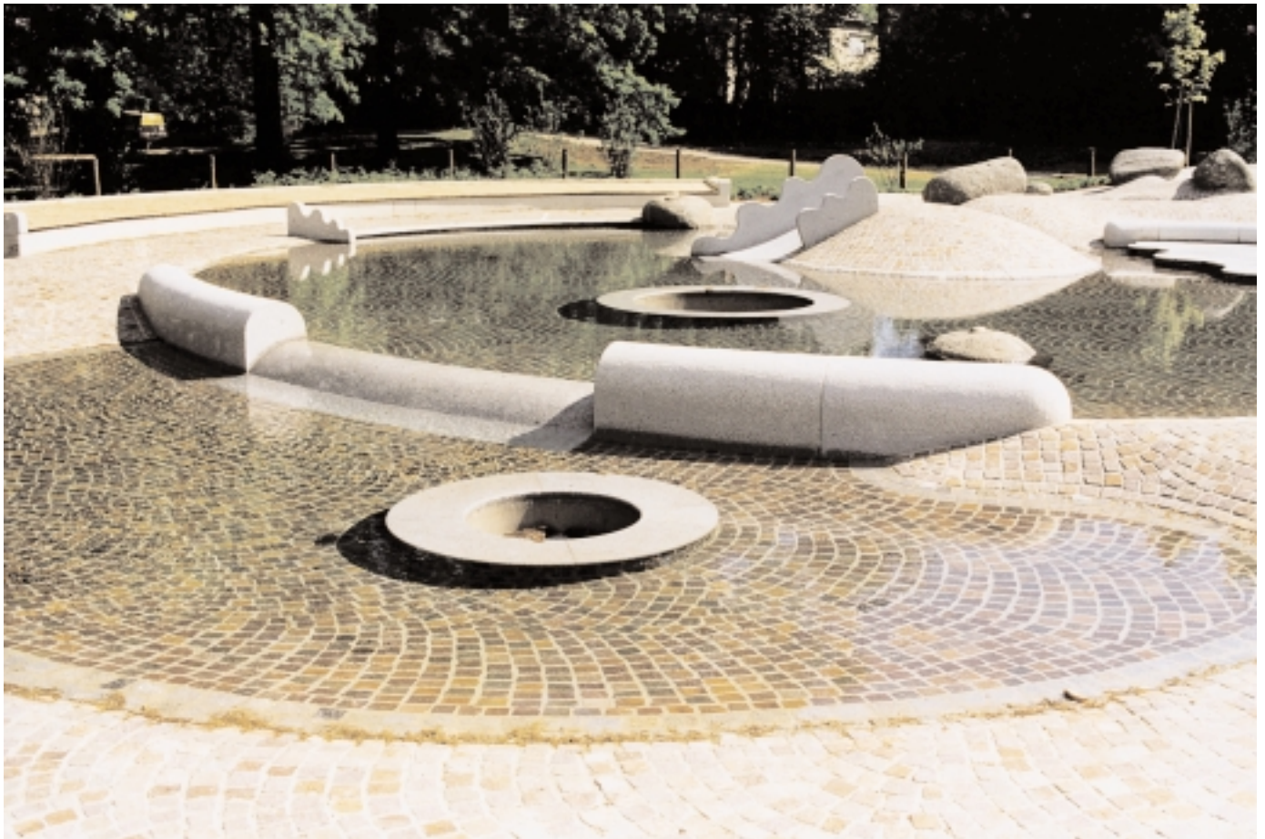
Kinderplischbecken Ungerbad mit Kleinkinderrutsche und Schläunden als Anschluß für die Rücklaufleitung
