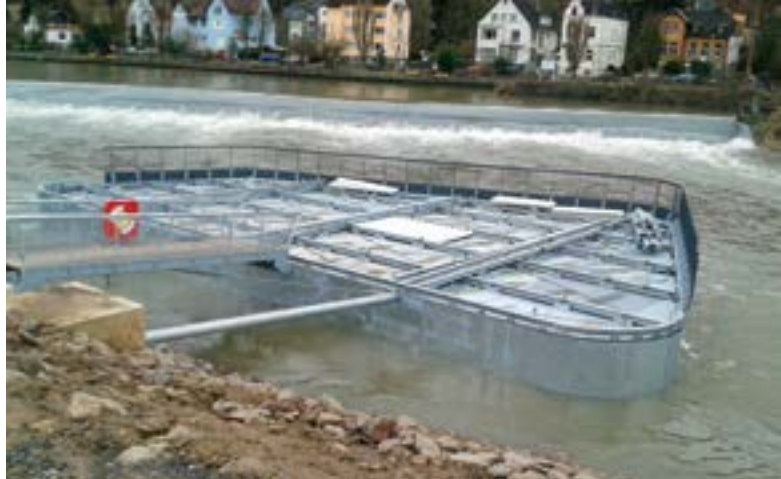
▲ Die schwimmende Tragkonstruktion
