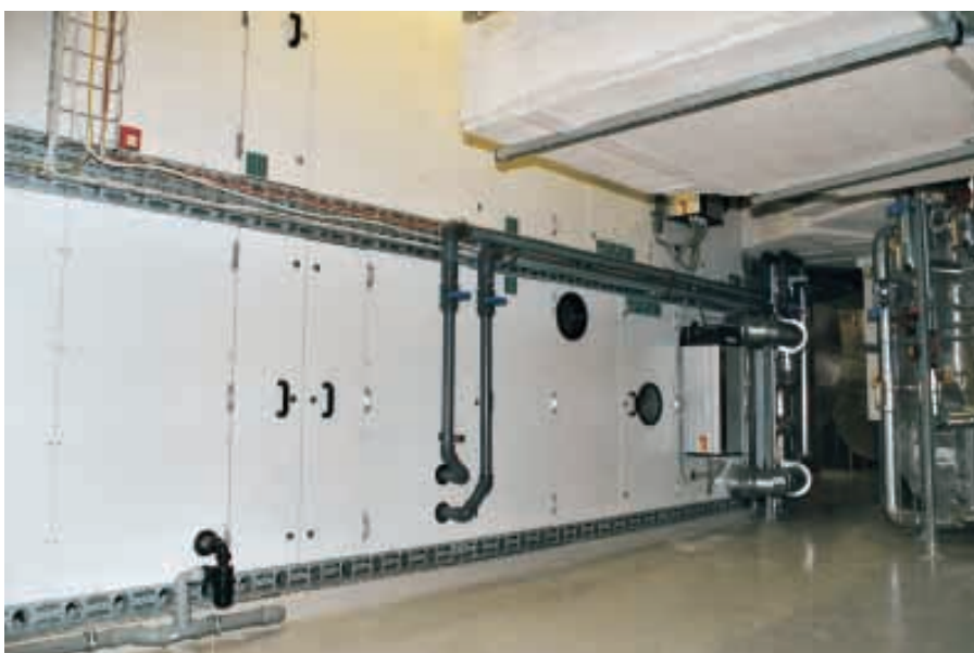
Fotos von oben nach unten: Wasserdichte Durchführungen an einem Schwallwasserbecken
