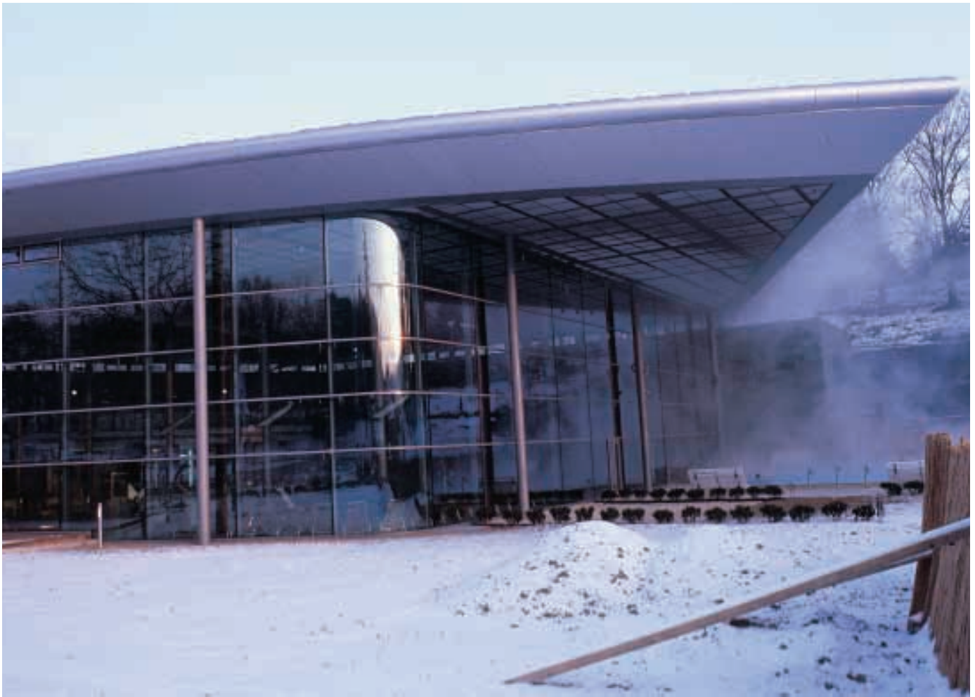
Fotos von oben nach unten: Kragdach über Außenbecken
