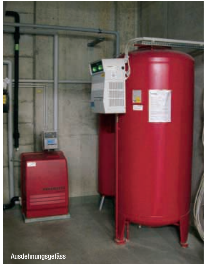
▲ Geschlossene Abwasserhebeanlage
