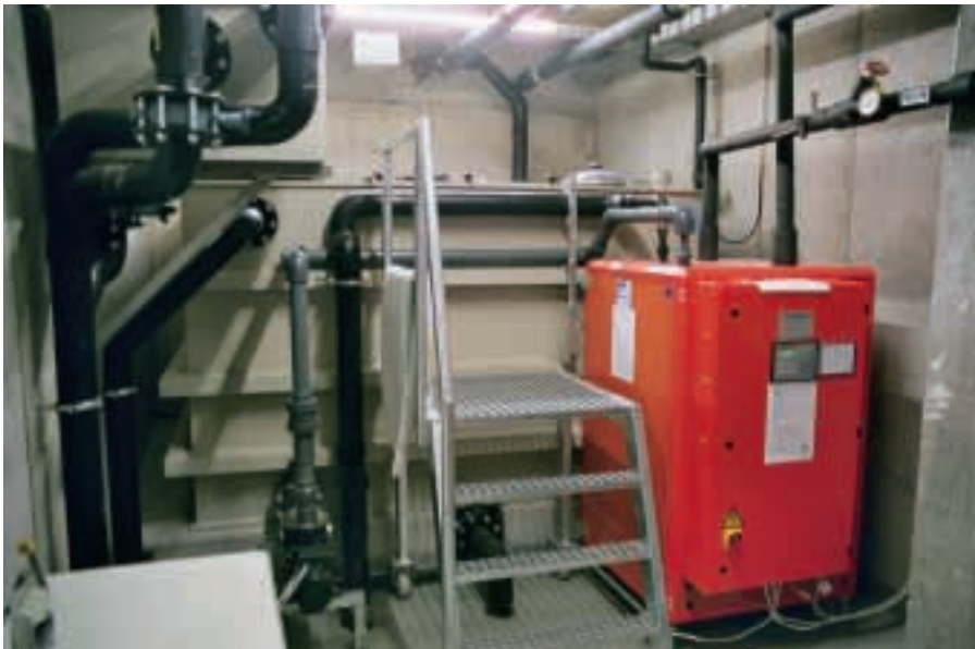
▲▲ Wärmeverteilung ▲ Duschenwasser-Wärmerückgewinnung
