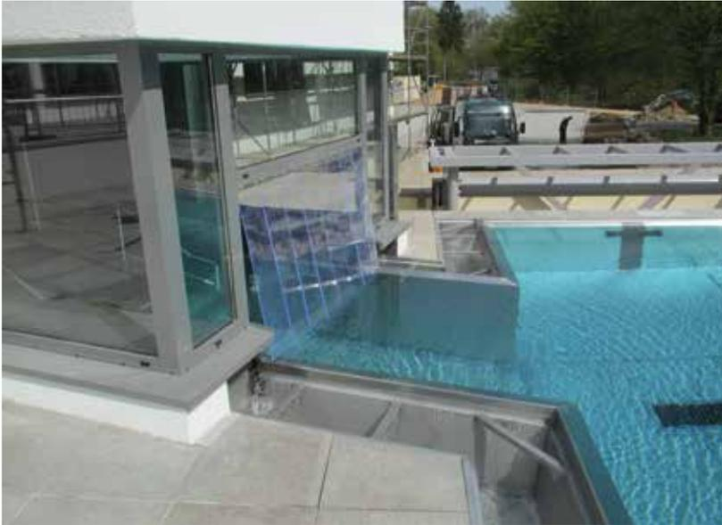
▲ Der Ausschimmkanal wurde neu in Edelstahl an das bestehende Gebäude angeschlossen.
