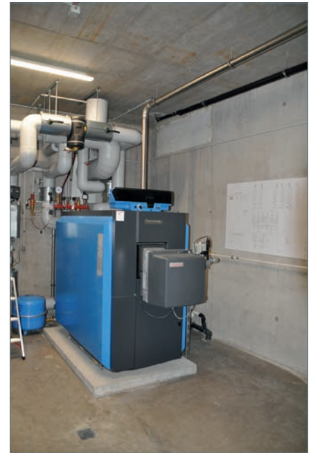
■ ... Gas-Brennwertkessel
