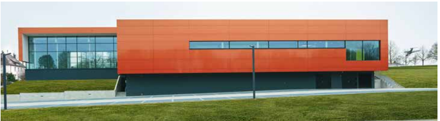
Ostansicht mit vorgelagertem Parkplatz
