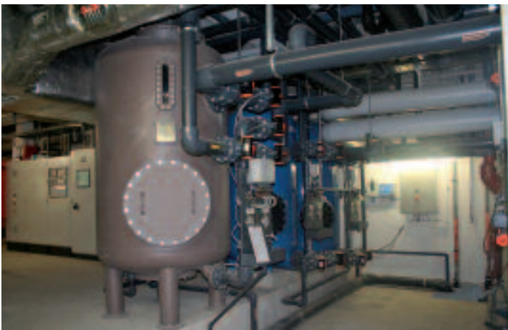
▲ Filtertechnik Kinderbecken und Schlammwasseraufbereitung
