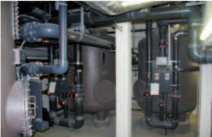
▲ Filtertechnik Schwimmer- und Lehrschwimmbecken
