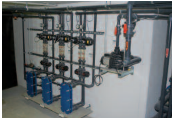
▲ Wärmerückgewinnungsanlage Stetszulauf/Stetsablauf
