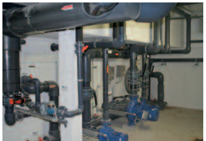
▲ Spülwasserpumpen
