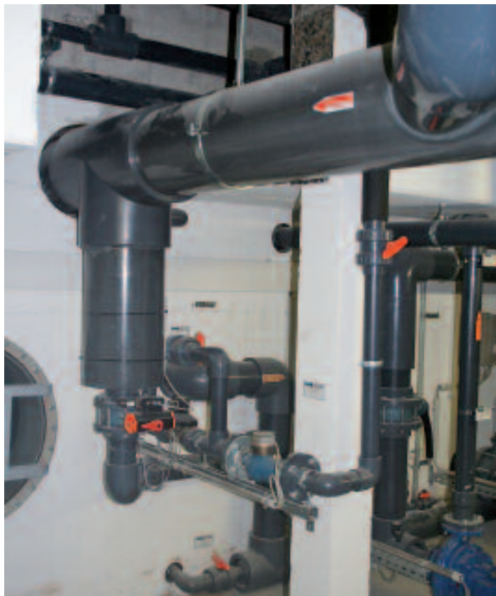
▲ Filtertechnik Kinderbecken und Schlammwasseraufbereitung
