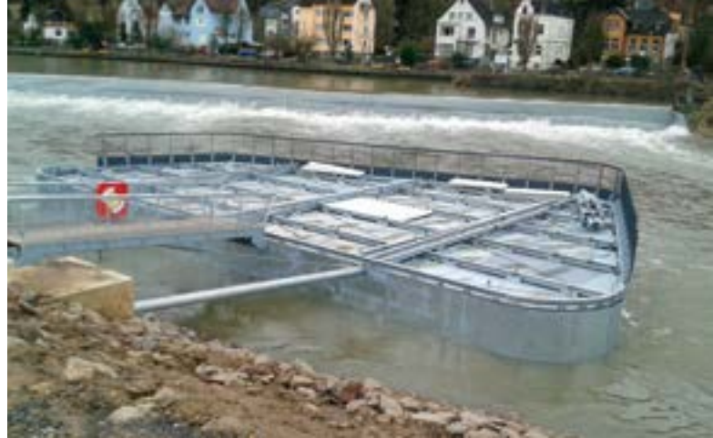
▲ Die schwimmende Tragkonstruktion
