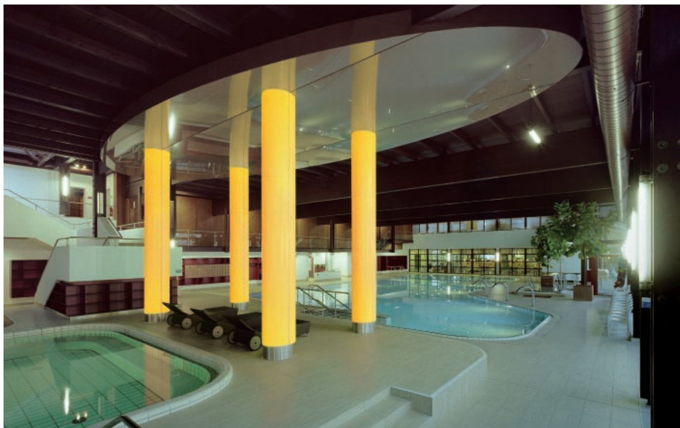
Lichtstützen in der Badehalle
