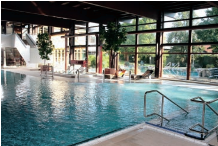
Das Innenbecken hat eine neue Durchströmung erhalten
