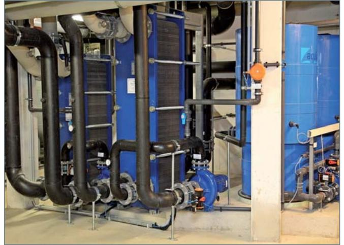
■ Differenzwärmetauscher der Beckenwasser-Wärmerückgewinnung
