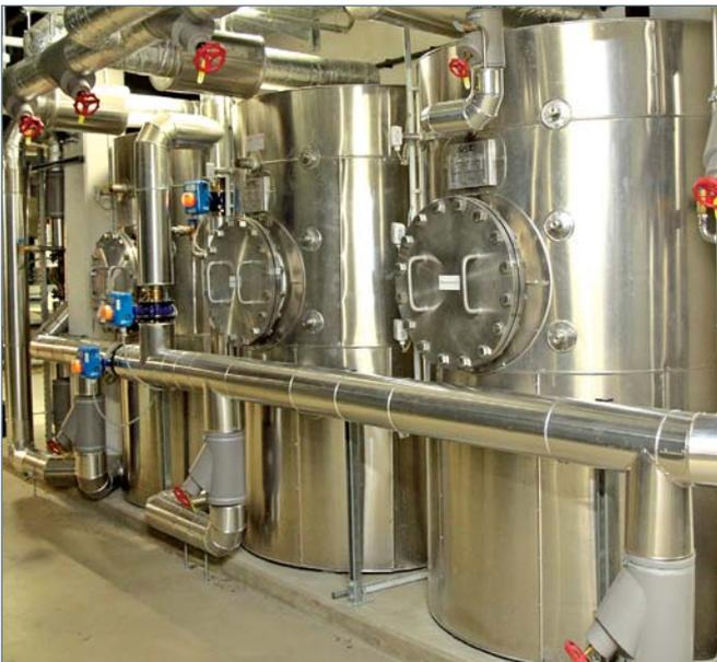
■ Warmwasserbereitung mit Vorwärmung des Thermalwassers
