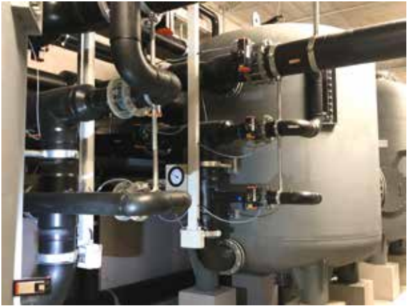
▲ Filteranlage neu
