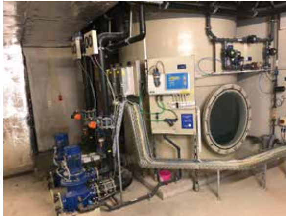
▲ Schwallwasserbehälter Kinderplanschbecken
