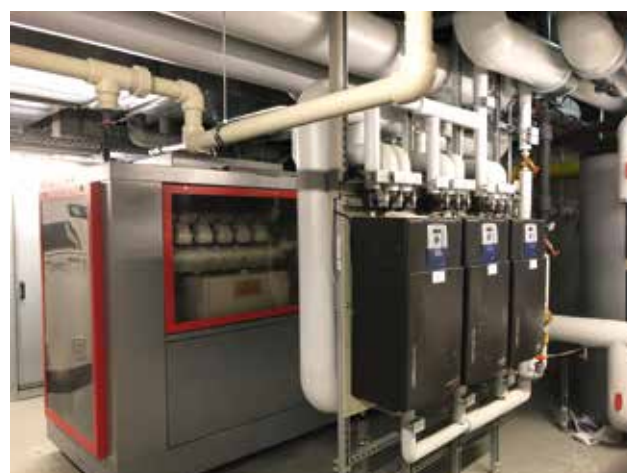
▲ Kaltwasserverteilung Rinnenspülung ▼ Blockheizkraftwerk
