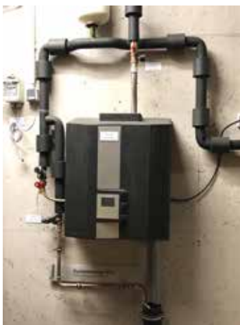
▲ Lüftungsanlage Sauna
