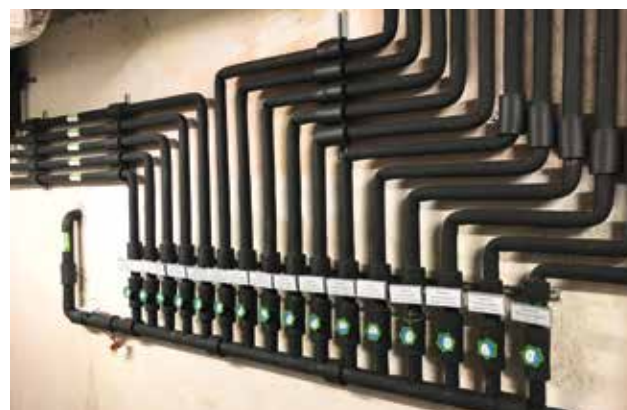
▲ Kaltwasserverteilung Rinnenspülung ▼ Blockheizkraftwerk
